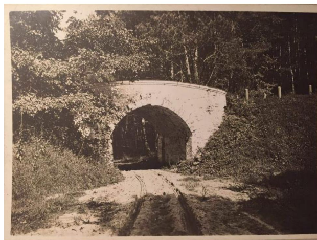
Мостик в Ильинском. Фотография. 1908 г. Собрание Д. Шлепнёва
